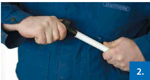
Abbildung 2: Kalibrierung und Entgraten des Rohres
