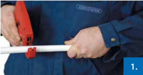
Abbildung 1: Ablängen des Rohres
