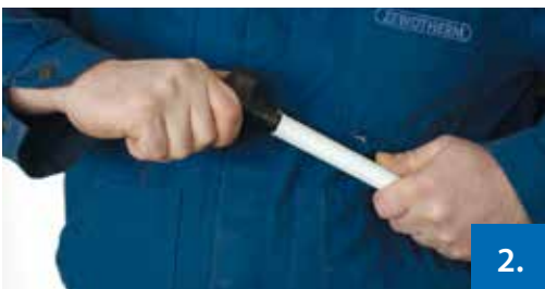
Abbildung 2: Kalibrierung und Entgraten des Rohres
