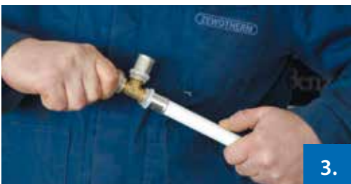
Abbildung 3: Einsetzen des Fittings
