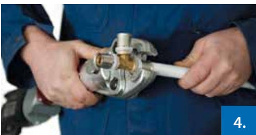
Abbildung 4: Verpressung / Beenden des Pressvorgangs
